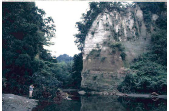
写真 11. 川廻し地形の変化. 写真 4 の白尾の川廻しの短絡部のトンネルは、後に崩れ、切り通しになった. 写真上, 藤原 (1979) より; 写真下, 1986 年撮影.
