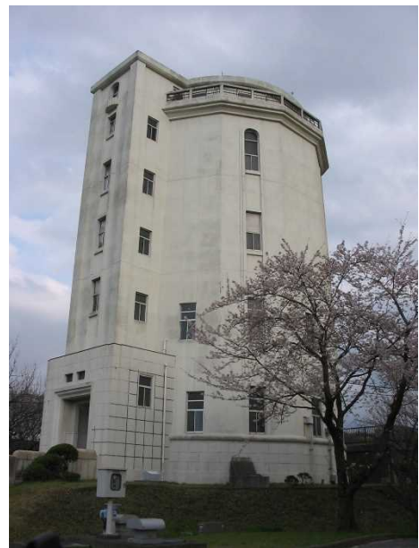
写真2: 千葉高架水槽
