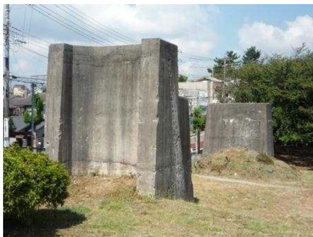
図4 鉄道演習線橋脚跡
