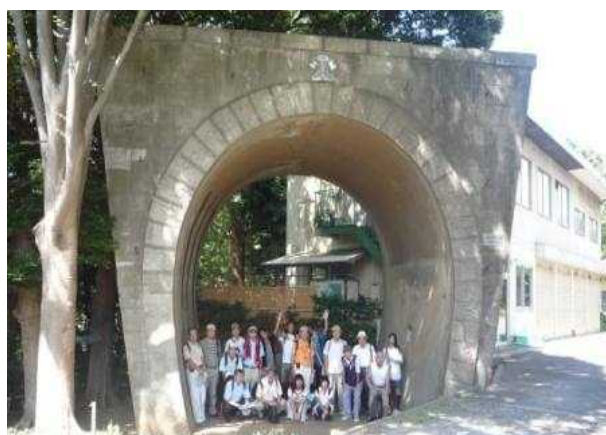
図 9 鉄道第一連隊演習用隧道にて
