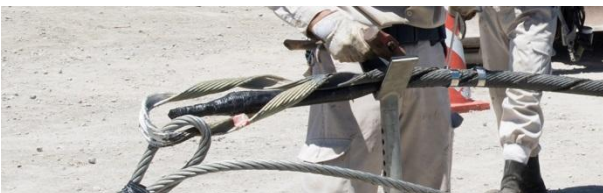
図 9 千倉に陸揚げされた FASTER の端部
