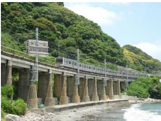
図 25 JR 東日本 山生橋梁
