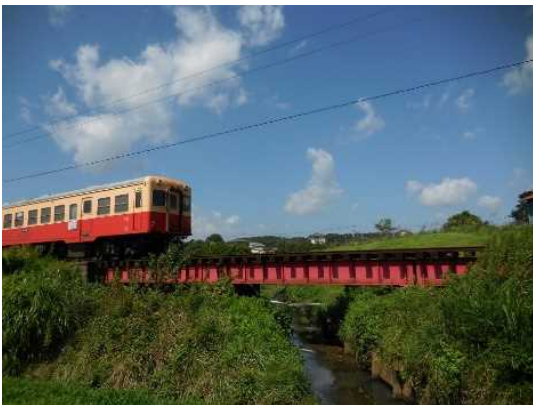
図 29 小湊鉄道線 第一柴の下橋梁
