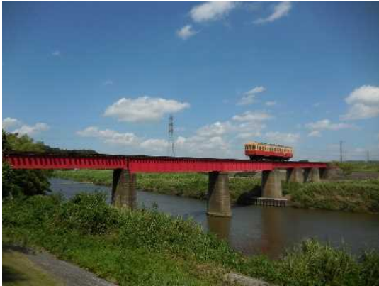
図 28 小湊鉄道線 第一養老川橋梁
