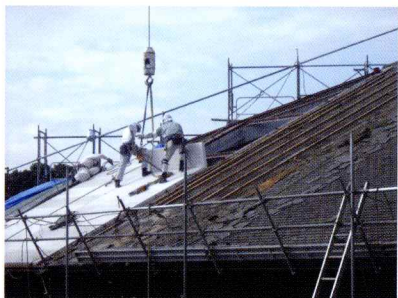
耐震補強工事の様子
