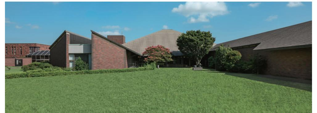
大高正人は「フラットルーフを追放せよ」と、日本の伝統的な屋根に回帰した「傾斜屋根」を提唱。千葉県立美術館はその「傾斜屋根の系譜」の初期作品のひとつ。外壁は師 前川國男が開発した打ち込みタイルを発展させた「先積ブリック打込工法」によるせつ器質タイル仕上げ。
