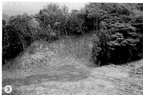
写真 3. 作業が完了した移植元の現場.
