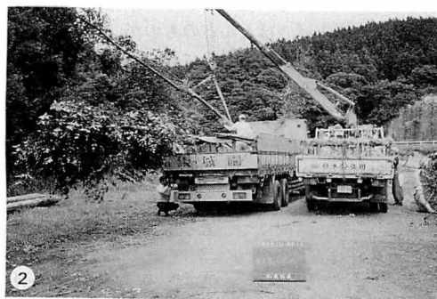
写真 2. 移植作業において高木を搬出.
