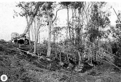
写真6, 7, 8. 移植先での樹木の植え付け作業。
