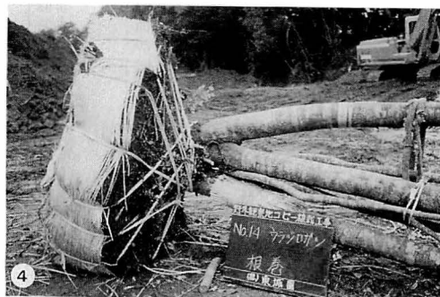
写真 4. 移植のため根巻した樹木.
