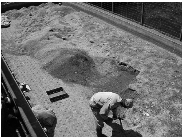
図4. ゼオライト充填濾過槽でのゼオライト交換作業。
