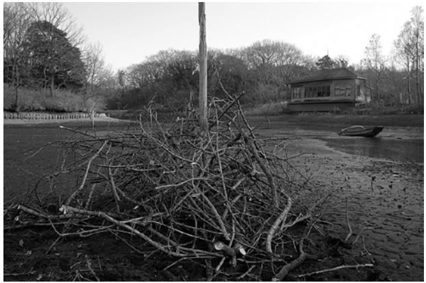
図6. 伐採した枝を水干し時に積み上げ構築した粗朶沈床。
