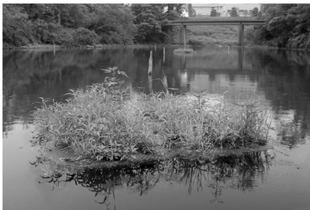
図 10. 浮力体を変更し植生が形成されつつある人工浮島。
