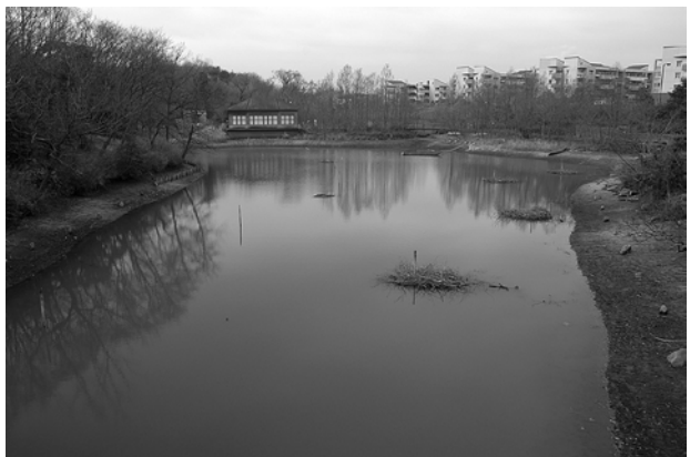
図7. 池西側の木杭4箇所を設置した粗朶沈床が湛水により水没する過程。
