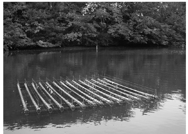
図8. 舟田池に設置した人工浮島（パイプ浮力体）。
