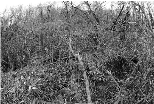
図 21. 木道が腐朽・崩落し藪化が進化した旧湿地。
