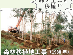
森林移植地工事（1988年）
