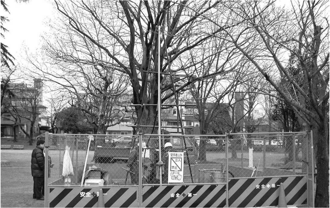
図3. 千葉市中央区本町におけるボーリング調査風景. 2009年2月, 撮影奥田.
