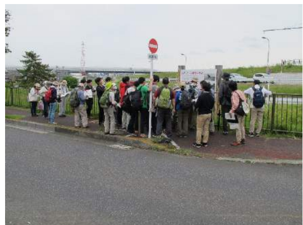
写真4 カスリーン台風で決壊した桜堤(葛飾区)
