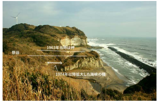
図14. 海食により1970年代に新しくできた島（銚子市小浜町）。
