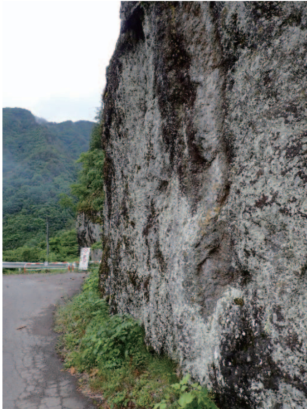
図3 (左). 池に沿った車道沿いの岩壁。岩肌は地衣類に覆われ、白っぽく見える。
