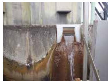
写真② 深さ数百mの井戸から汲み上げられているかん水（(株)合同資源千葉事業所。長生村七井土）。
