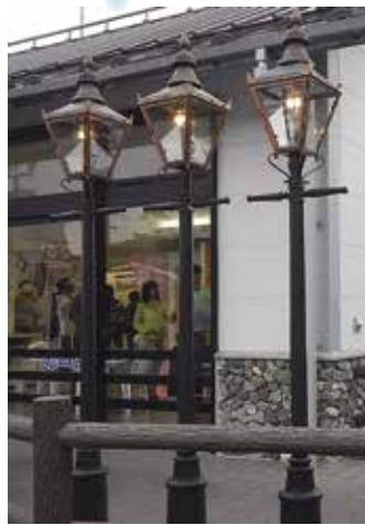
写真① 大多喜町天然ガス記念館前のガス塔。電球の代わりにガスで発光させるガスマントルを使っています（大多喜町大多喜）。
