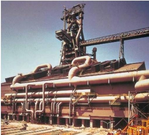
君津製鐵所 第4号高炉
