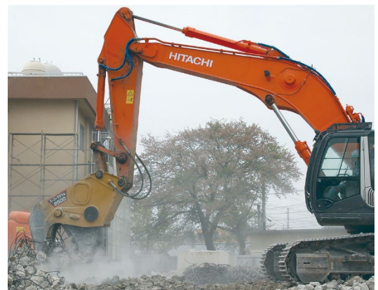
油圧ショベルに取り付けられた油圧式解体機
