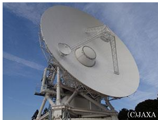
勝浦第 4 送受信局用パラボラアンテナ
