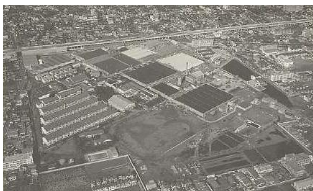
取り壊し前の中山工場
