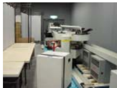
図3 撤去作業中の映写室
