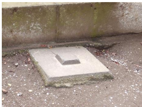
写真3 堀江水準標石（整備前）
