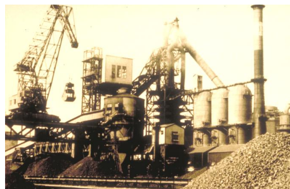
図4 川崎製鉄千葉製鉄所 第1号高炉
