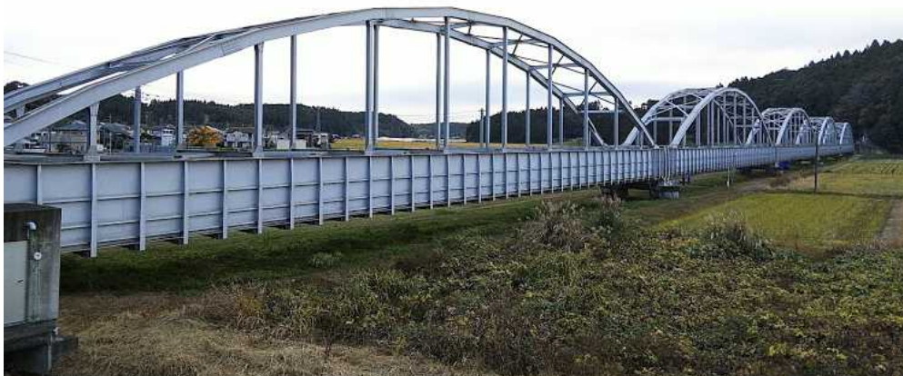
写真 1 : 公平水路橋 (外観)
