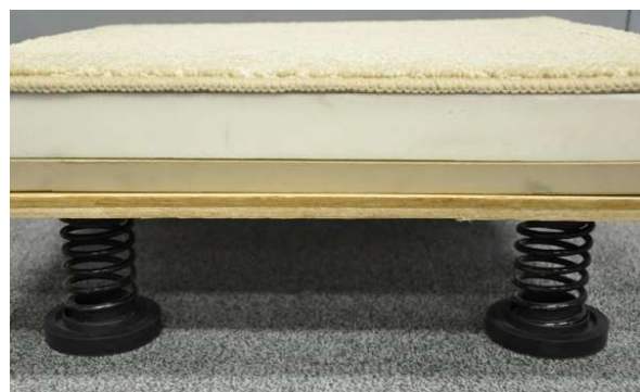
スプリング式ゆかカットモデル：性質の違う 2 種類のクッションの組み合わせで、反発力と衝撃吸収を両立させ、底面には高性能スプリングが付いています。
