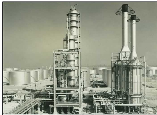
写真2: 1号蒸留塔全景(昭和38年)
