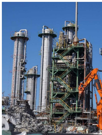
写真 3 : 解体状況③
