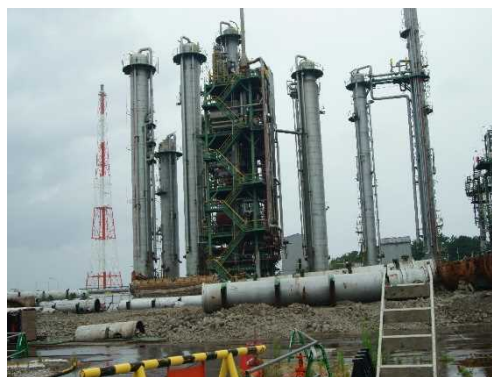
写真 4 : 解体状況④
