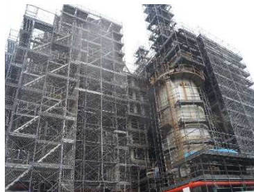
写真 2 : 解体状況②
