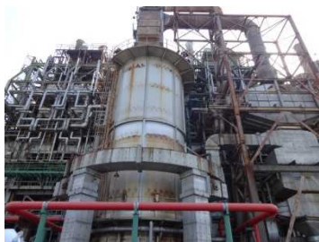
写真 1 : 解体状況①
