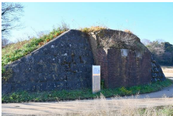
写真1：物井川橋りょう亀崎橋台跡
