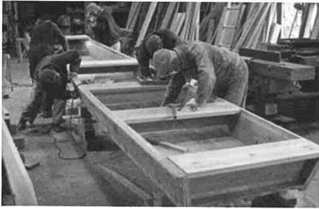
S工務店作業場にて製作中。もうすぐ完成だ。
