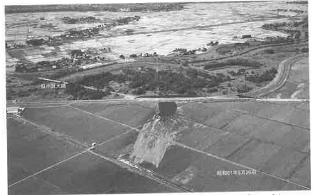
写真-5 昭和61年小貝川洪水・明野赤浜地先破堤の「おっぼり」
